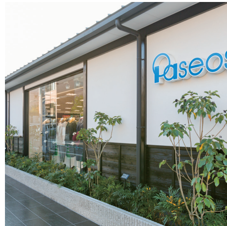
パシオス伏見丹波橋店
